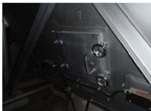
バグフィルタの点検口
