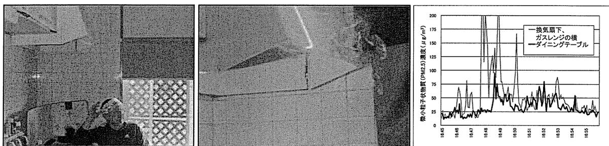
図 5.4.2. 換気扇からはみ出すタバコ煙によるリビングの汚染 (受動喫煙)
