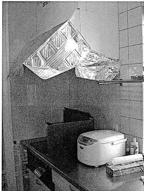
図 5.5.2. 台所の換気扇の排気効率を改善する工夫
