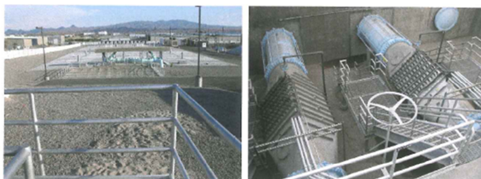
図 4.23 アリゾナ州 Havasu 湖の Havasu 湖水処理プラントに設置している WEDECO K143。UV システムは屋外の地下に置かれ、26 MGD（98,000m 3 /日）のろ過した地下水を処理している。将来増設のための閉止フランジと複数の照射槽の上の埃に注意が必要。
