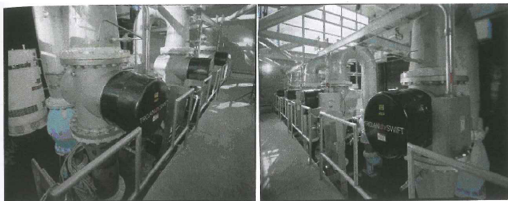
図 4.24 オンタリオ州 North Bay (カナダ) の Trout 湖水処理プラントで未ろ過水 21MGD (79,000m 3 /日) を処理している Trojan UVSwift™ の照射槽。
