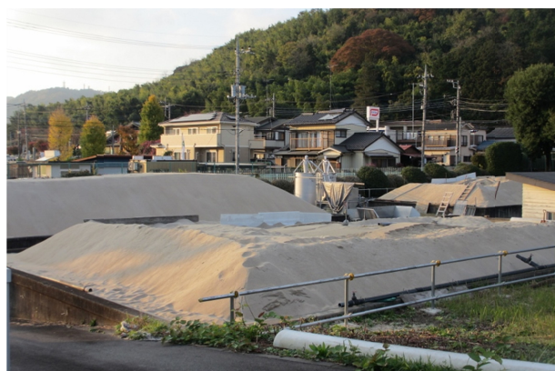
洗砂機及び洗砂置き場
