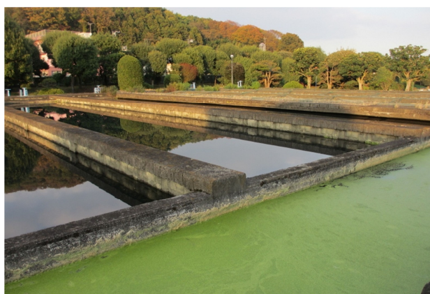
緩速沈澱池（手前は浮き草）
