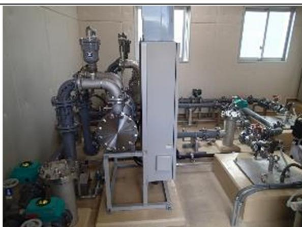
写真-15：紫外線処理設備 2 系列
