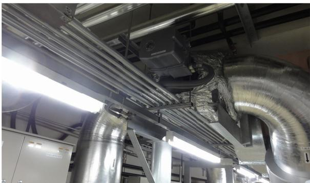
装置二次側緊急遮断弁（配管頂部）
