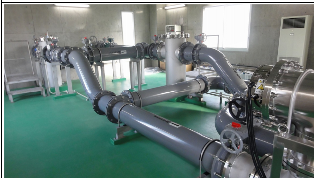
原水濁・色度計（左）、原水監視用水槽（右）
