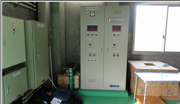
紫外線処理装置制御盤
