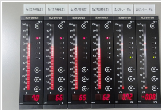
紫外線処理装置制御盤
