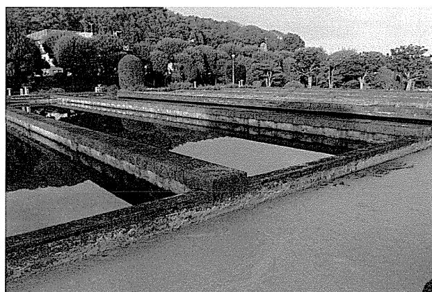
緩速沈澱池（手前は浮き草）
