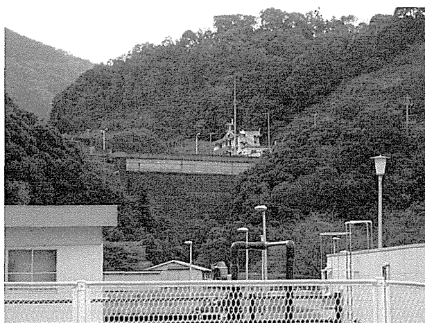
写真-2 : Kk 浄水場からダムを望む
