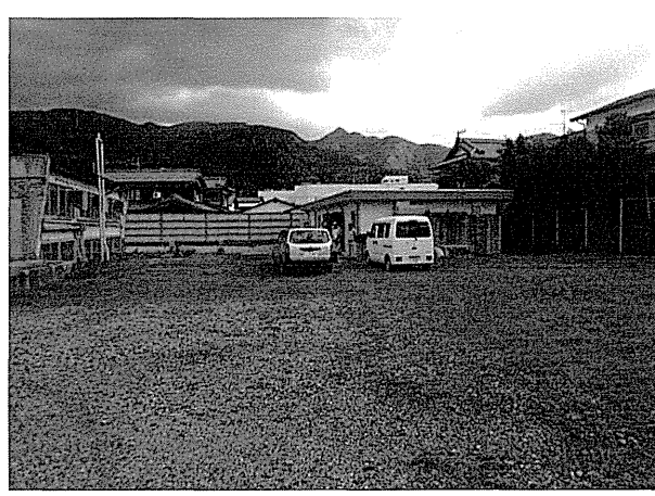
写真-6 : 紫外線処理棟 (右) と送水ポンプ室 (左)
