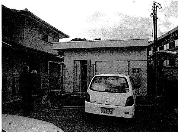
写真-13 : Ng 浄水場 住宅地に近接、建屋内に井戸あり
