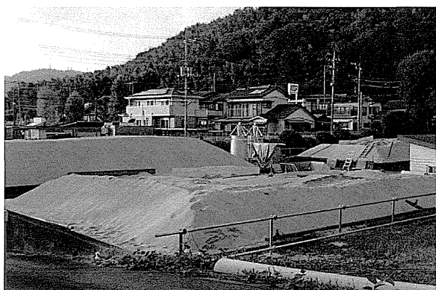
洗砂機及び洗砂置き場
