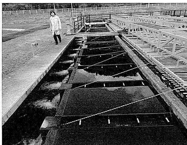
写真-4 : 傾斜板沈澱池出口設置 (トラフに活性炭入り袋を設置)
