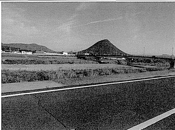
集水埋管 (伏流水) 箇所
