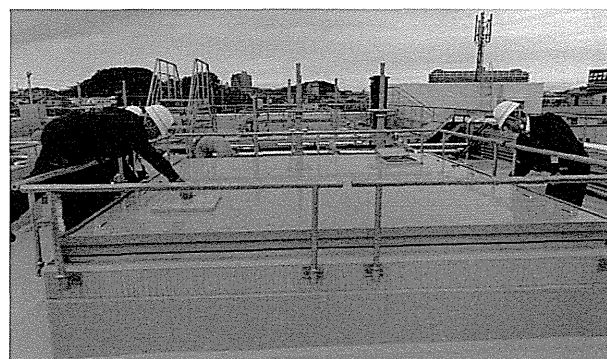
ろ過池点検口（建屋屋上）
