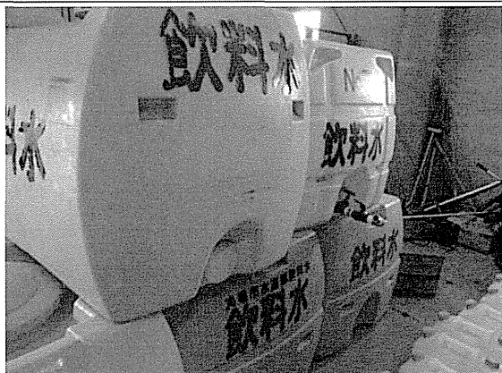
飲料水タンク
