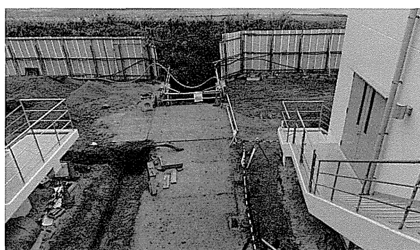
建屋から地上を見る（地盤から嵩上げしている）
