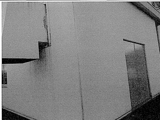
自家発電設備建屋 (地下は浄水池)
