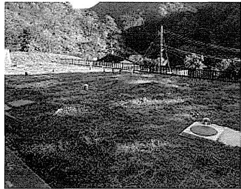
浄水処理建屋前の配水池
