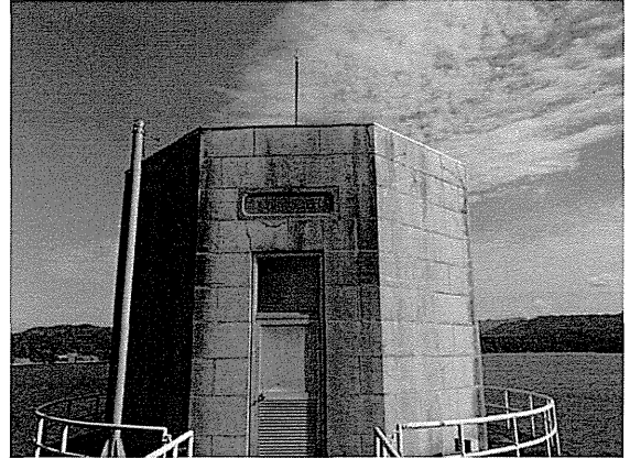
Mn 池取水塔
