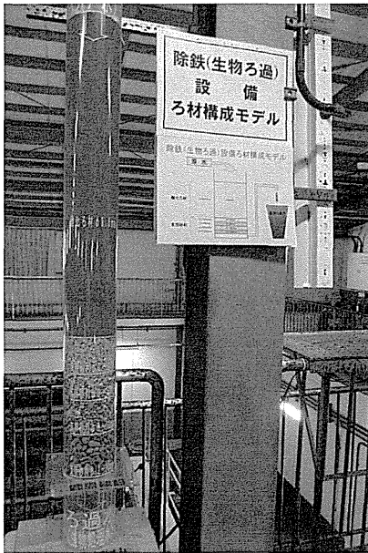
除鉄 (生物ろ過) 設備ろ材構成モデル
