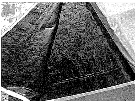
高速凝集沈澱池 (2)
