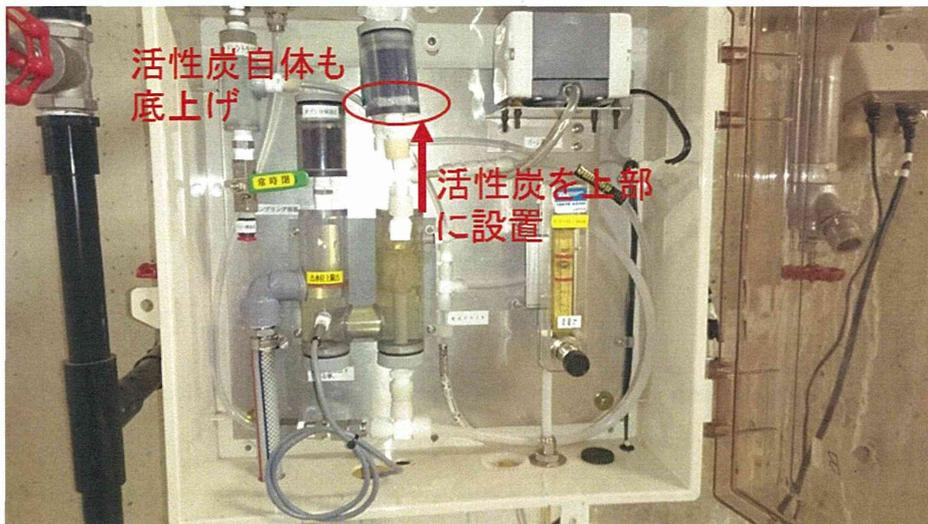
図4 活性炭に関する工事後の溶存オゾン濃度モニターの気液分離部前面
