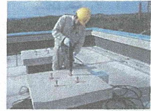
アンテナ架台固定作業
