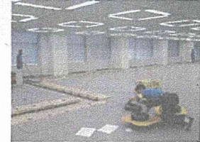
室内外の配線・配管作業
