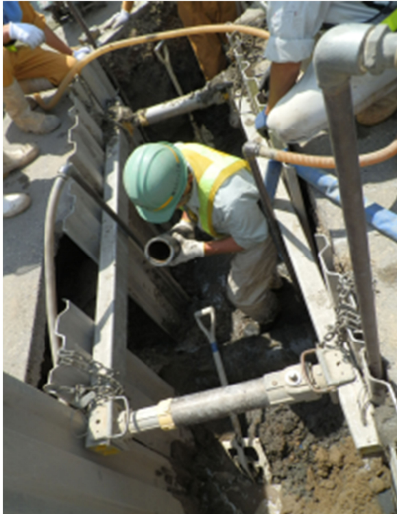
図3 布設替え工事と採取(表2の試料1、2に対応)
