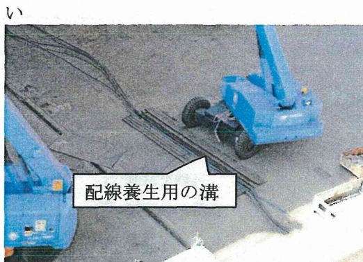
写真2 配線養生用の溝
