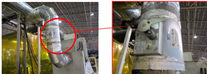
図 7.26 フード1~4の風量調整ダンパー（左：全体図、右：拡大図）
