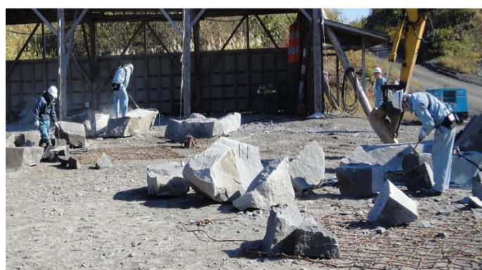
図 4.7 作業場全体の作業風景（その 3）
