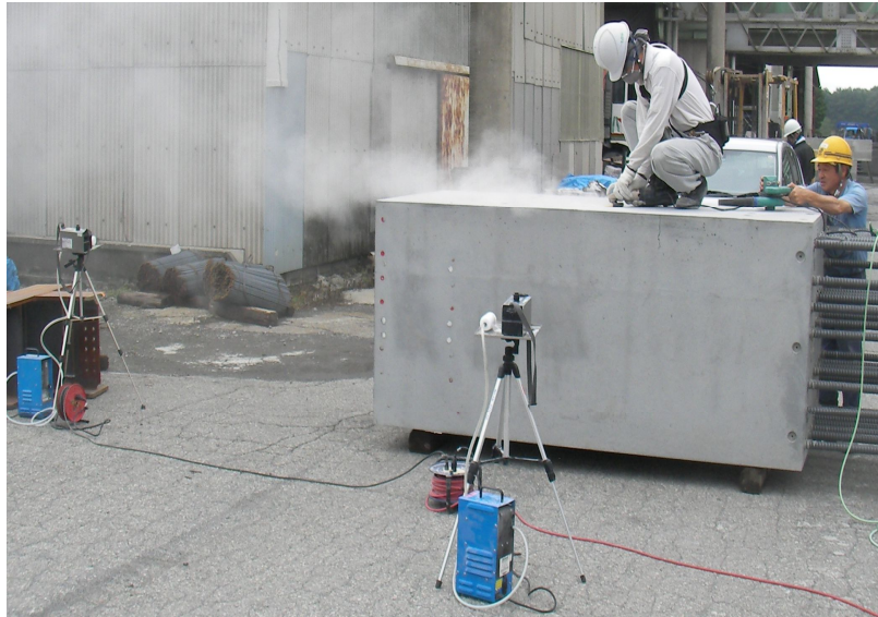
図 1.4 コンクリートに対する研磨・ばり取り作業の測定
