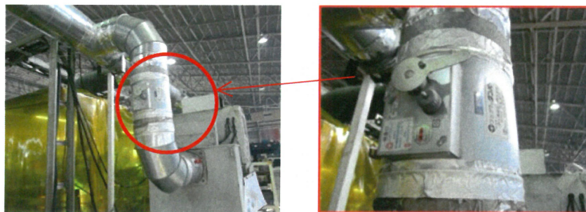
図 7.26 フード1～4の風量調整ダンパー（左：全体図、右：拡大図）
