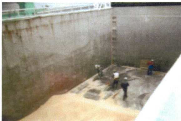
図 5.24 船底での清掃作業状況 (その 1)
