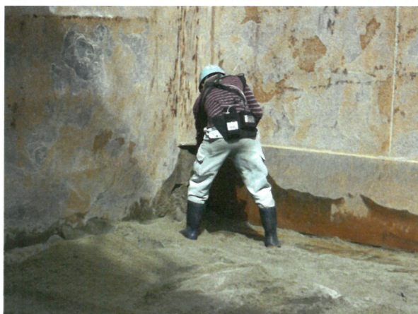
図 5.10 船底での清掃作業状況 (その 1)
