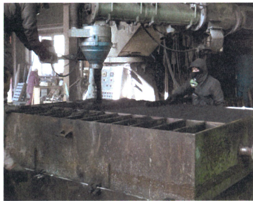
図 2.4 手込め作業風景
