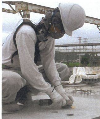
図 1.2 コンクリートに対する研磨・ばり取り作業の様子
