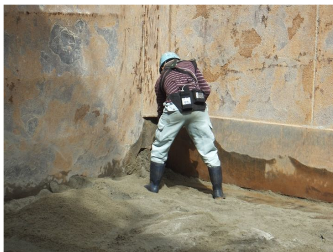
図 3.11 船底での清掃作業状況（その 1）
