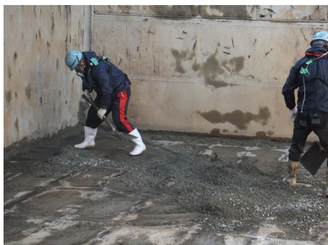
図 3.4 船底での清掃作業状況
