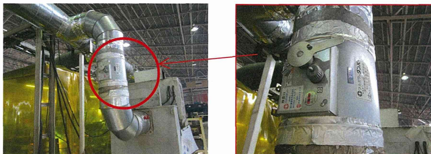
図4.99 フード1～4の風量調整ダンパー（左：全体図、右：拡大図）
