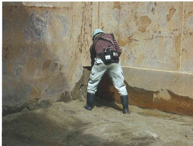
図 3.11 船底での清掃作業状況（その 1）
