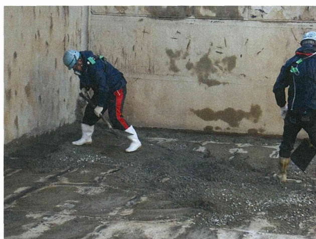
図 3.4 船底での清掃作業状況
