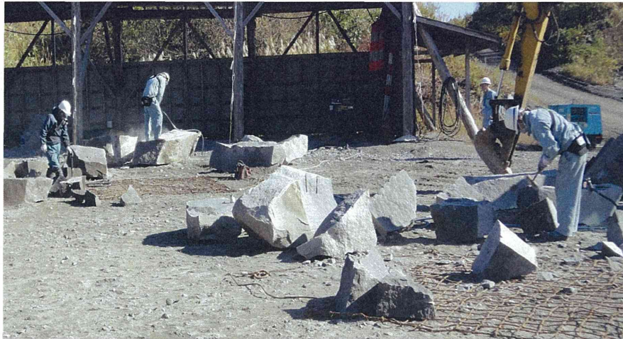
図 2.8 作業場全体の作業風景（その 3）
