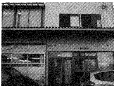
写真 4：元ガラス工場の建物を活用した多機能型事業所
