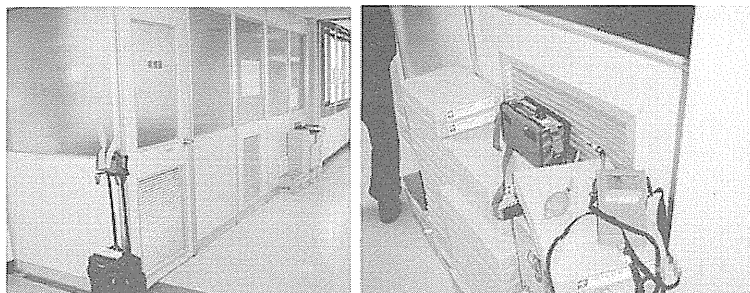
図5 廊下の一角にパネルで作られた喫煙室 (左：喫煙室全景と押し込み式のドア，右：出入口と反対側のガラルの外側に設置された粉じん計)
