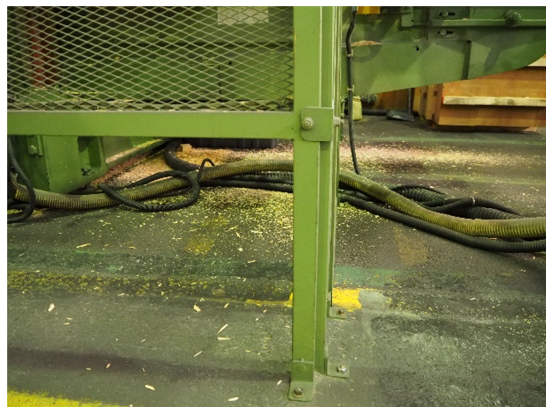
写真 22 ( 作業床の木材粉塵 )
