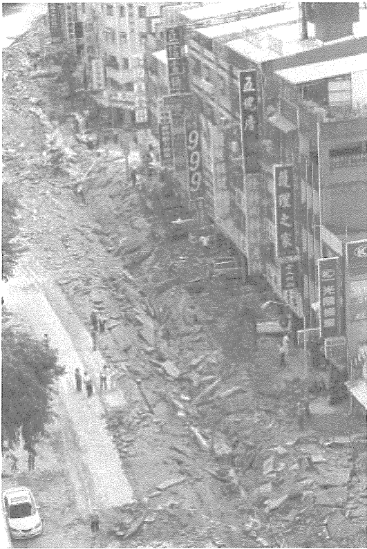
パイプラインの爆発で陥没した道路
