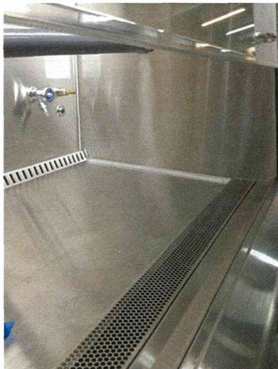
BHC 全面吸込部 正常運転中
