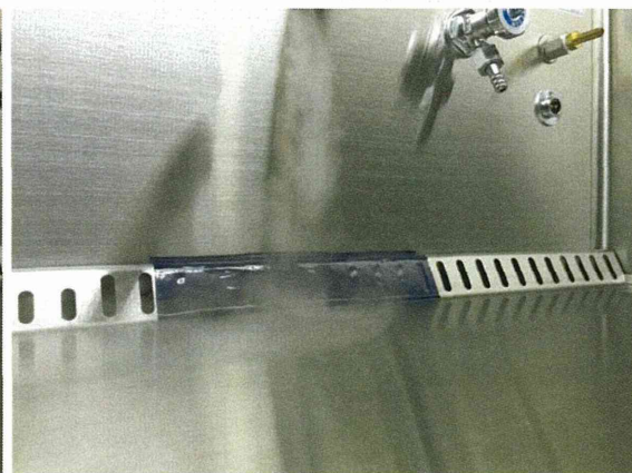
テープにて吸込部を防いだ状態(テープ幅 200mm)
