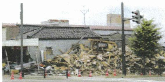
▲ 柏崎市の被害状況。地震動に耐えきれず倒壊した古い家屋。
