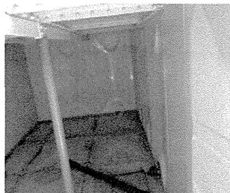
タンク内部の立上配管が破損。配管サポートの設置がない。修理すれば、使用可能。
