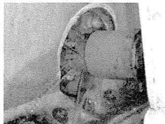
タンクと配管サポート間に、可とう性継手(フレキシブルジョイント)の設置がなく、継手破損。修理すれば、使用可能。
