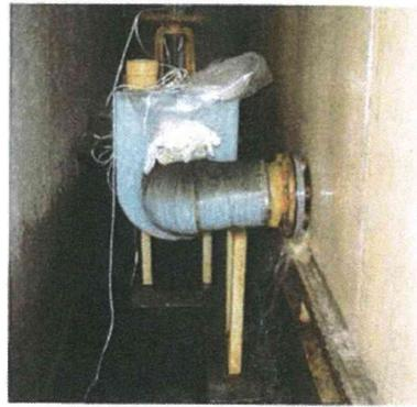
震災被害による漏水の一例
