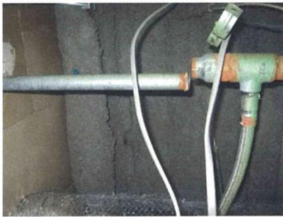
スプリンクラー配管の破損
