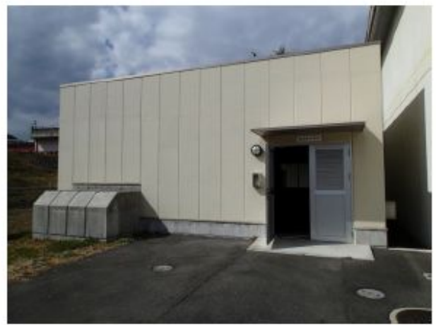
紫外線処理棟
