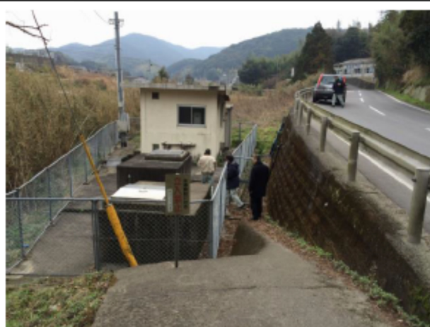
K○水源地（手前は井戸、その左は河川）
