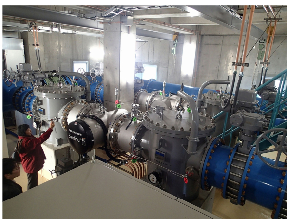
2 系列（下流側から）
