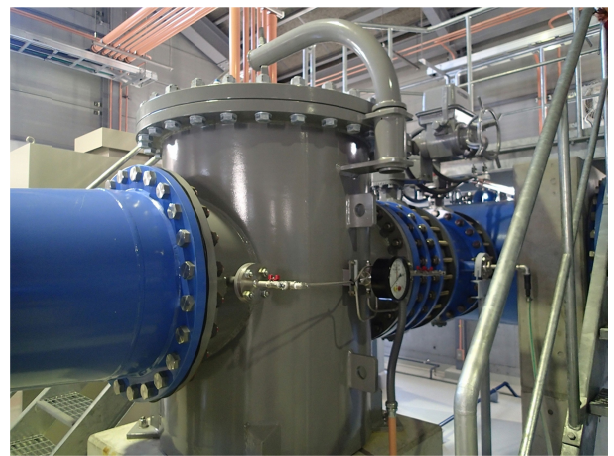
フィルター（紫外線照射装置の前後に設置）
