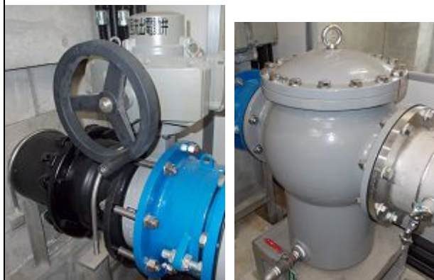
流出弁と UV 流出側ストレーナー
