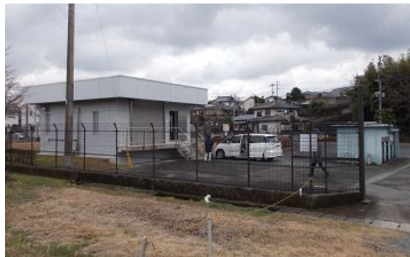
紫外線処理設備の建屋、その奥と横に水源
