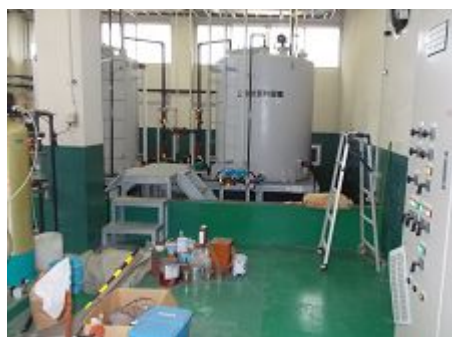
次亜塩素酸注入設備。12%次亜を購入、左端の装置で生成した純水で倍に希釈後、注入。
