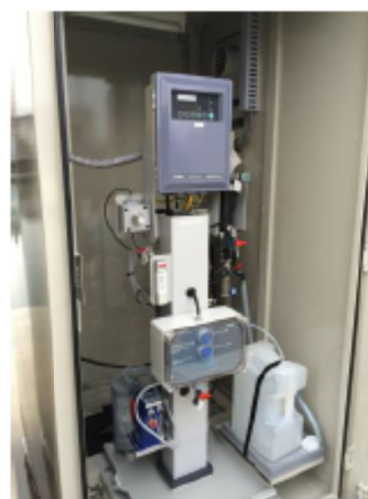
緩速ろ過水濁度計
