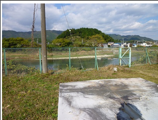
S川（手前コンクリート下が集水部の一部）
