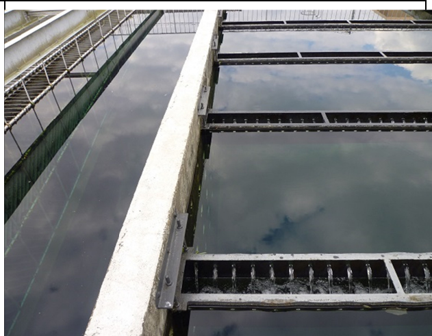
傾斜版沈殿池(写真左側)と流出トラフ
