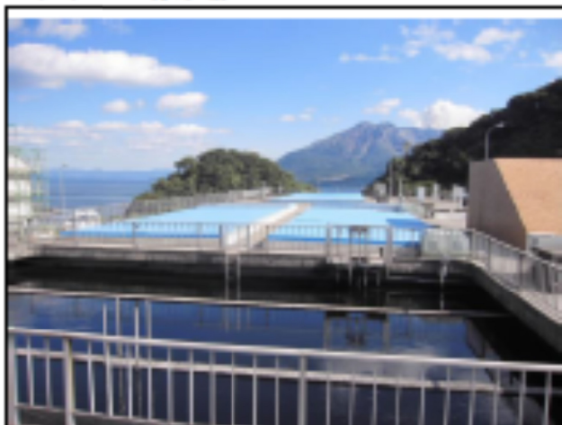
手前から、ブロック形成池、沈殿池、ろ過池 (奥にS島が見える)
