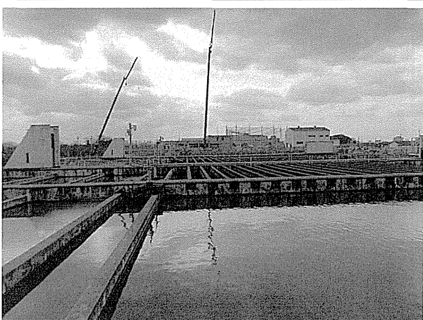
傾斜板の無い沈澱池と有る沈澱池（奥）
