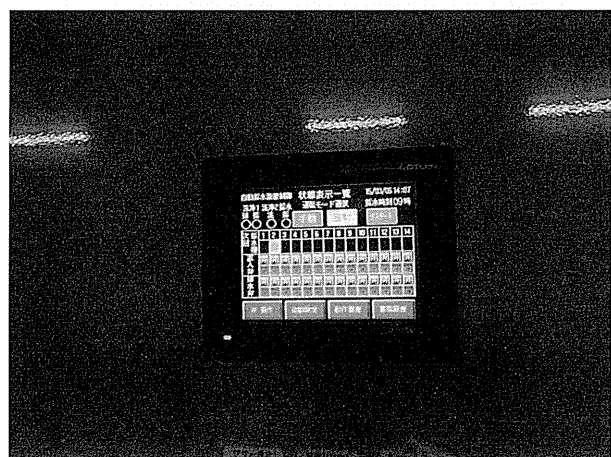
自動浄水採水装置の操作盤
