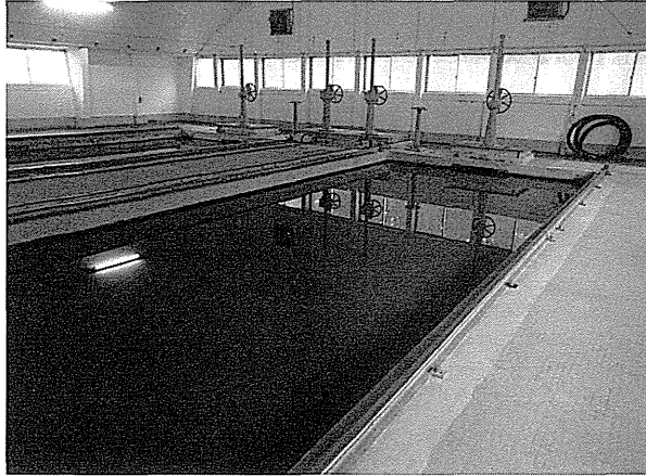
旧ろ過池を利用した排水池
