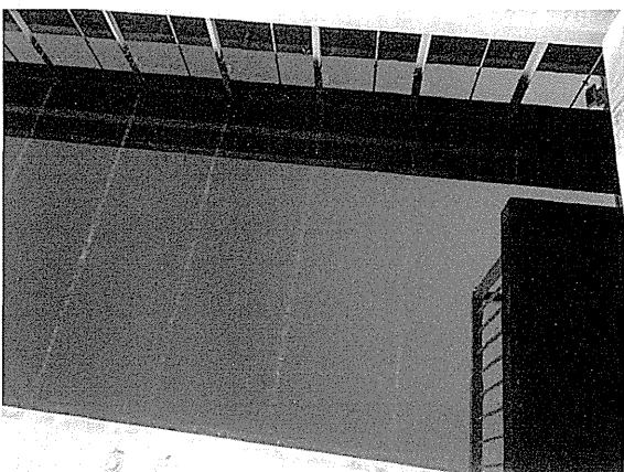
沈澱池 (凍結防止用エアープ)
