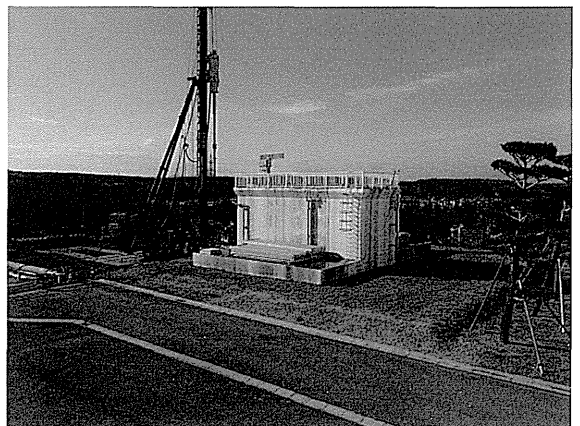
着水井と粉末活性炭接触池 (建設中)
