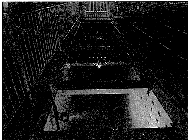
沈澱池流出トラフ部
