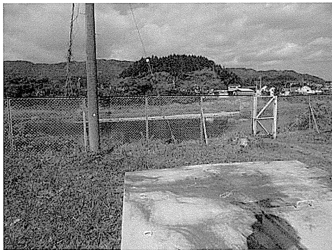
S川 (手前コンクリート下が集水部の一部)
