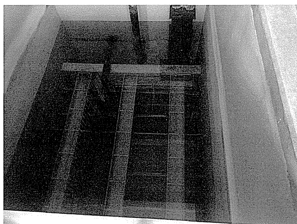
ろ過池内部 (運転休止中)
