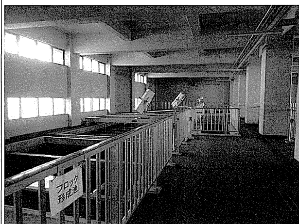
ブロック形成池+沈澱池
