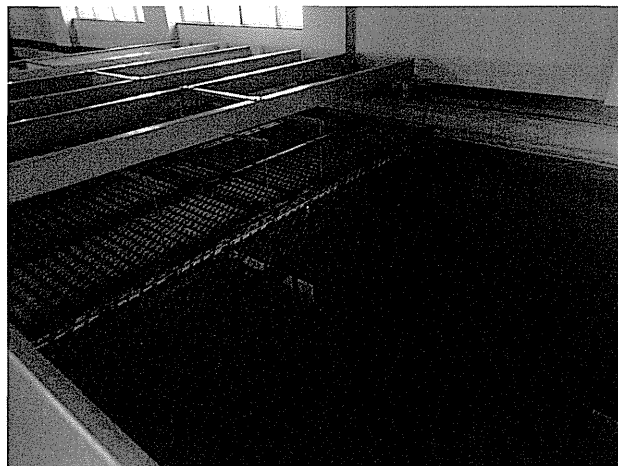
沈澱池傾斜板
