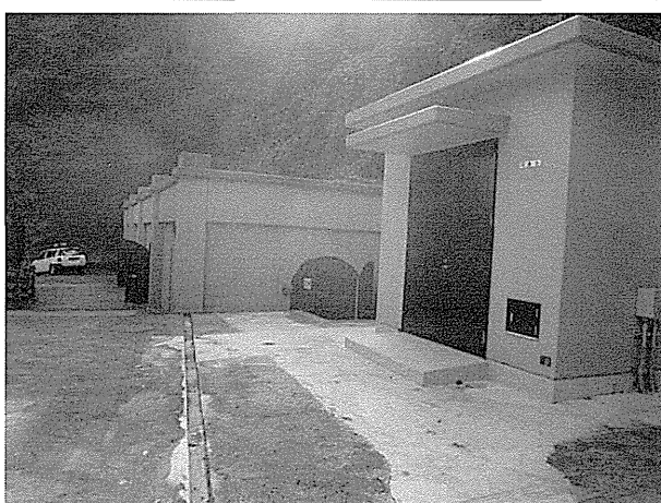
奥：紫外線処理建屋、手前：塩素注入建屋
