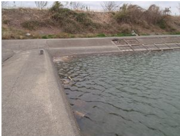
図 6-1 2014年3月26日の磯部頭首工 右岸写真
