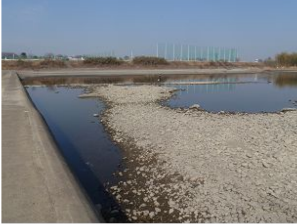
図 5-1 2014年2月26日の磯部頭首工 右岸写真
