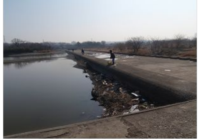
図 5-2 2014年2月26日の磯部頭首工 写真
