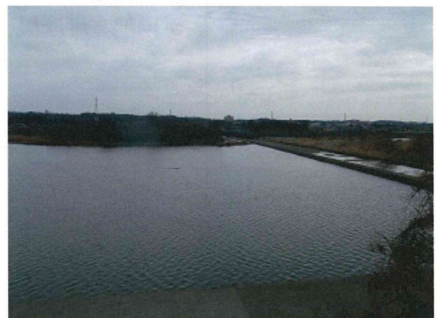
図6-2 2014年3月26日の磯部頭首工写真
