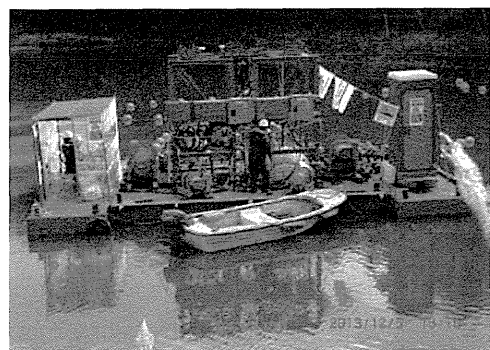
写真4 ため池の表層底泥の除去の実証実験
