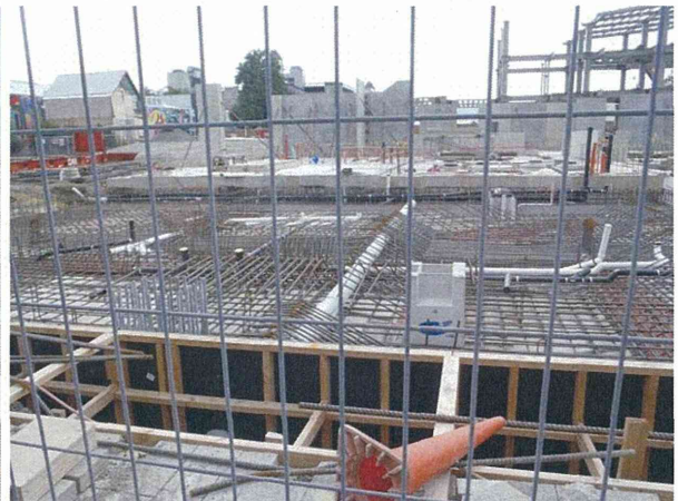
新築工事中の建物
