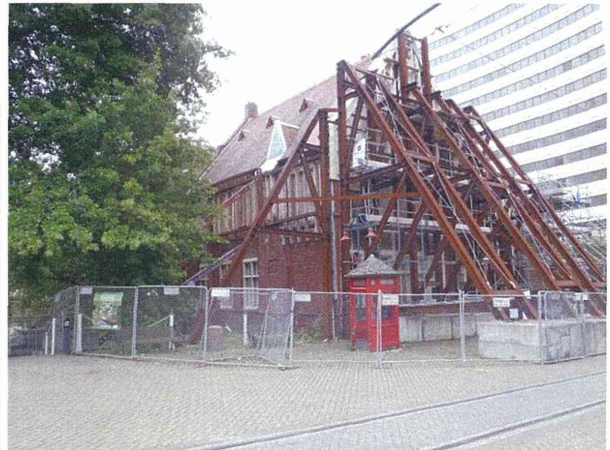
鉄骨による補強がされている
