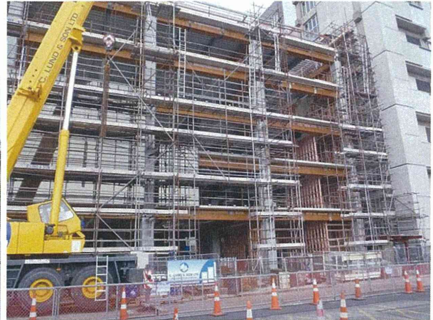
建設中のクライストチャーチ市役所別棟
