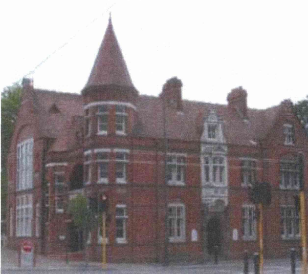
被災前の旧市議会議場
