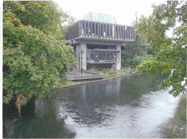
エイボン川岸壁が沈下している
