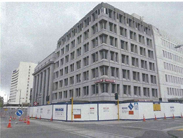
立ち入り禁止の建物
