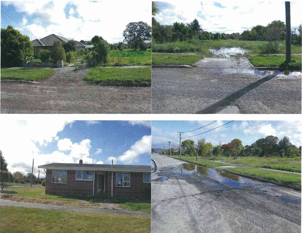
写真-6.9 Burwood 地区の被災状況
