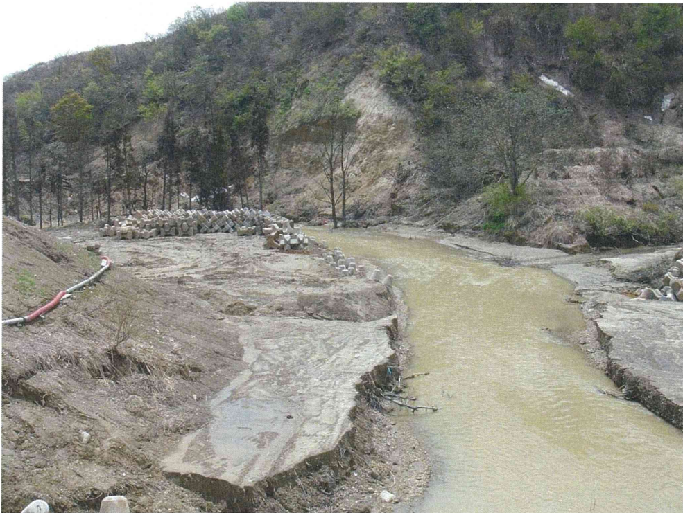
東竹沢地区災害復旧工事の様子（河道閉塞後の対策工事） （2006年5月12日 伊藤和也撮影）
