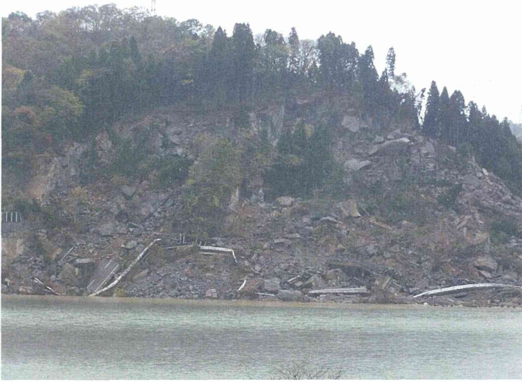
長岡市妙見町の県道が斜面崩壊によって通行不能となった。
