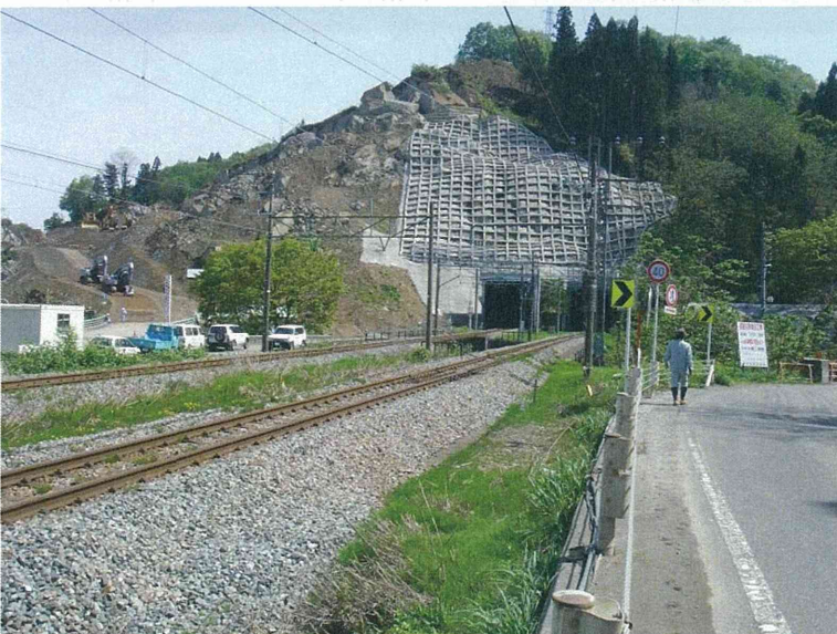
復旧作業が進む県道（左）（長岡市妙見町）
