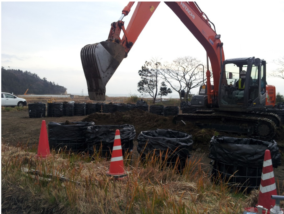
写真1 重機によって汚染土壌がフレコンバックに回収される
